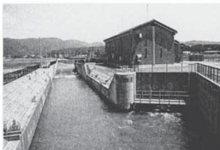
農業用水を有効利用した七ヶ用水発電所
